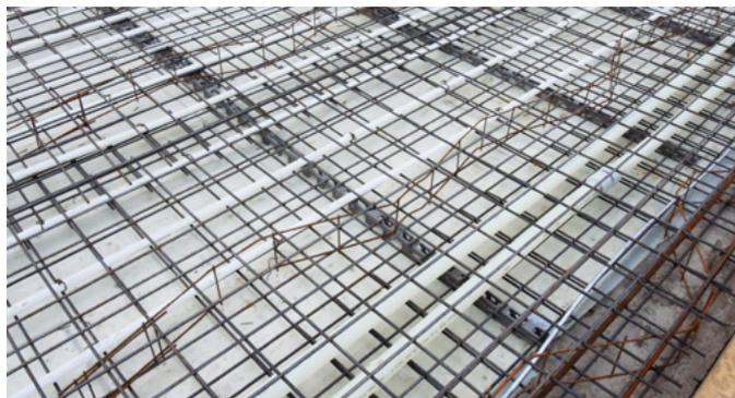
In den Beton sind wasserführende Rohrleitungen, meist aus Kunststoff, eingelegt. Durch diese wird dann im Winter warmes (Wand-, und Fußbodenheizung) und im Sommer eben kühles Wasser geleitet, das den Beton entsprechend temperiert und im Sommer der Raumluft die Wärme entzieht. Eine gute Planung ist für den effizienten Betrieb besonders wichtig.
