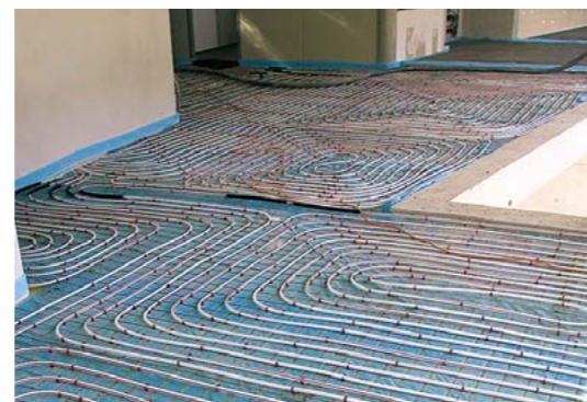
Abb. 28 | Fußbodenheizung
